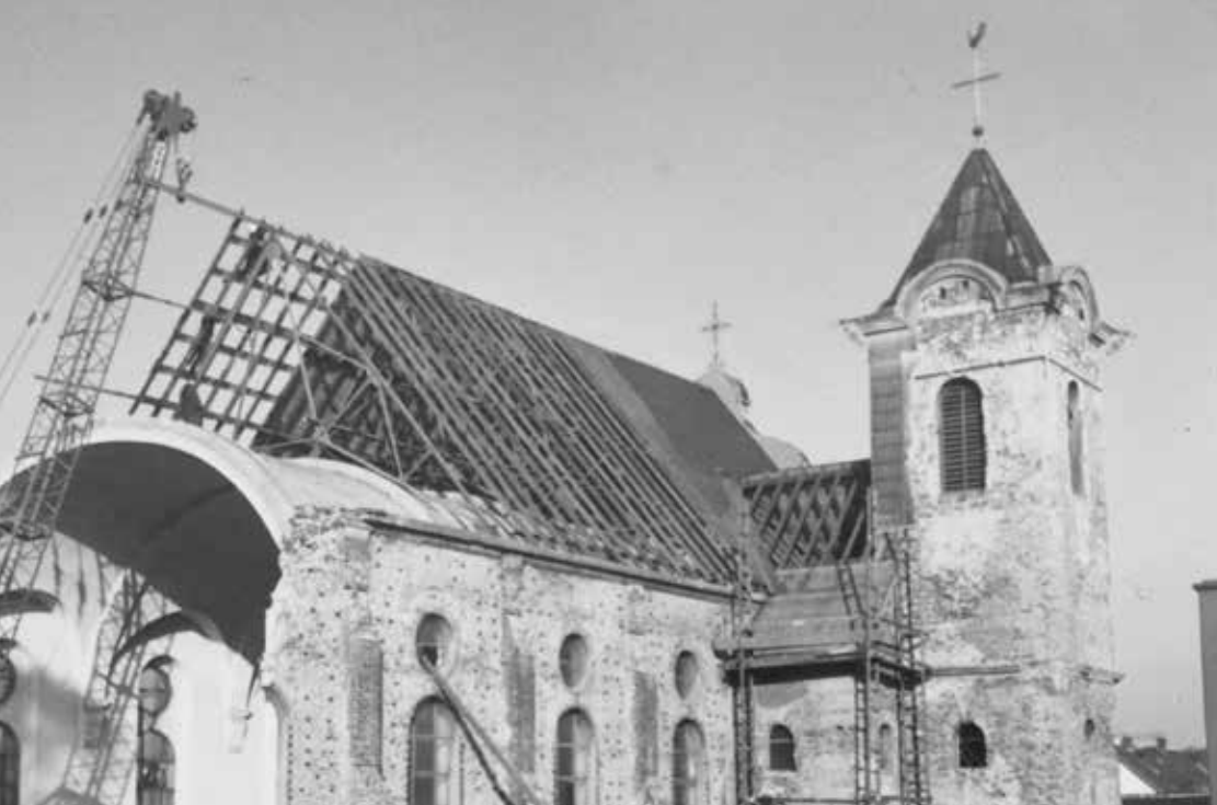
Abriss der alten Ronsdorfer katholischen Kirche.
